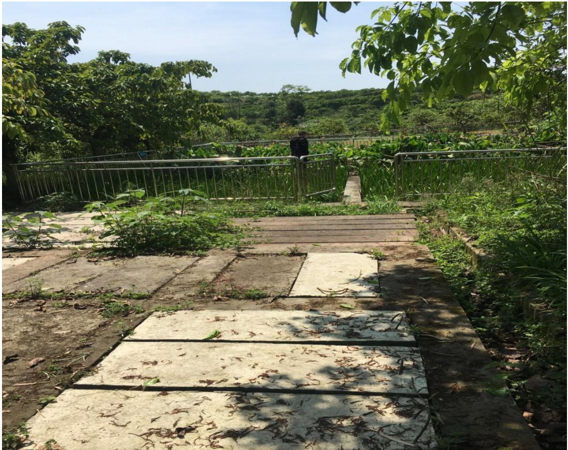
图5-6 某试点二级人工湿地实景图
