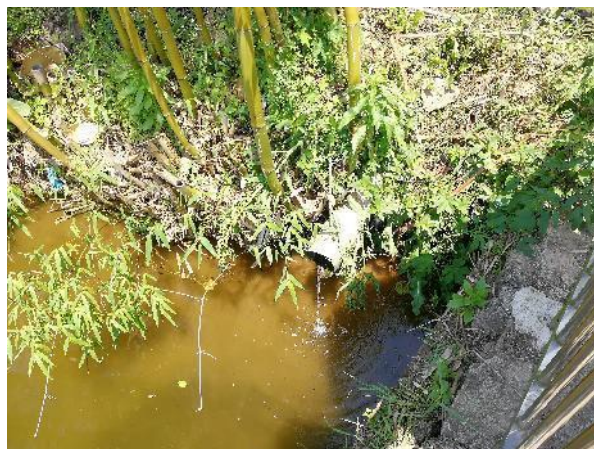
污水排入河流现状
