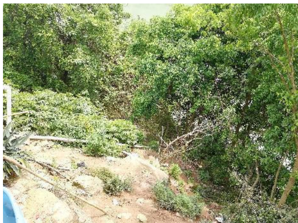
污水排入河流现状
