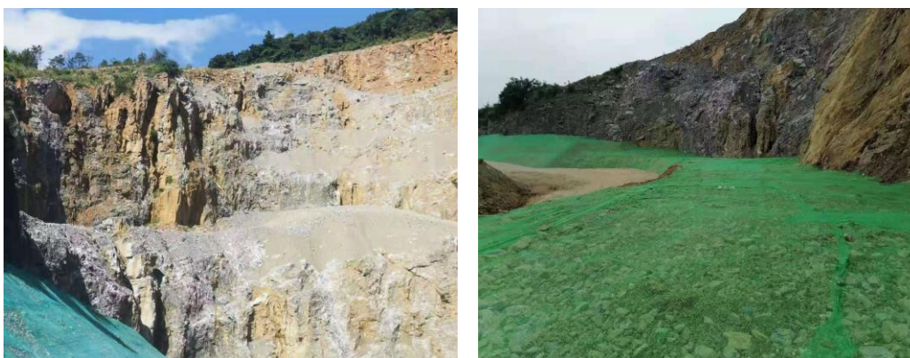
原矿区开采现状
