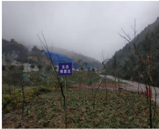
破碎生产区生态修复治理
